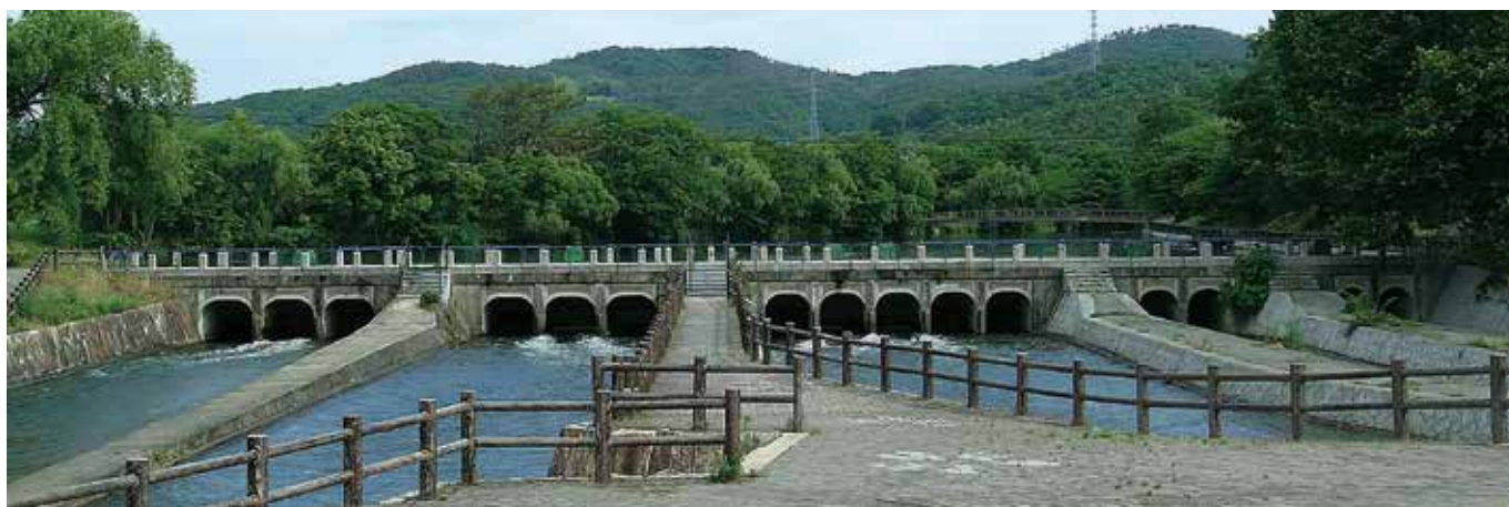
現存するものとしては国内最大級の15連の南配水樋門 樋門後方が配水池。船穂や玉島にいく西岸用水、西阿知や水島にいく南部用水、それと倉敷用水など、5つの水路へ配水を調整する大規模な樋門。
