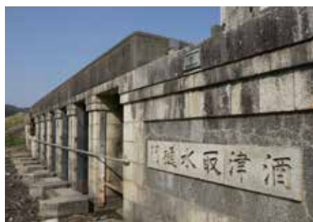
笠井堰から取水する水門 ここから、高梁川の水が配水池へと送り込まれる。
