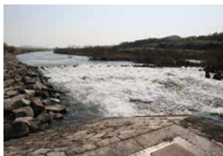
高梁川の改修時にもうけられた笠井堰。
