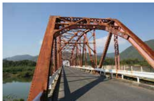
大原橋鋼製トラス橋
