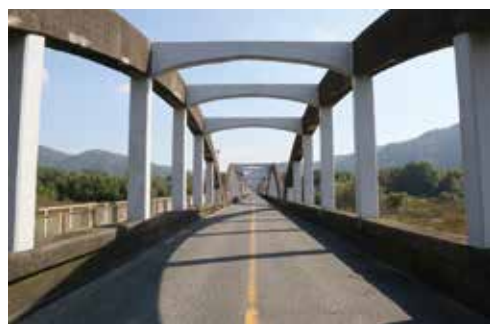
大原橋コンクリート部
