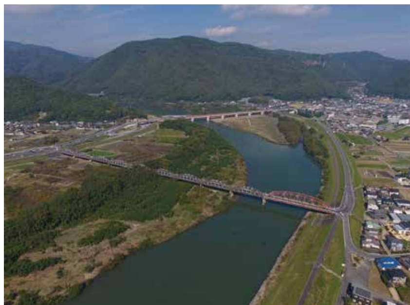
鋼製トラスと9連のコンクリートのアーチが並ぶ大原橋
