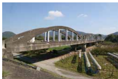
大原橋の鉄筋コンクリート部
