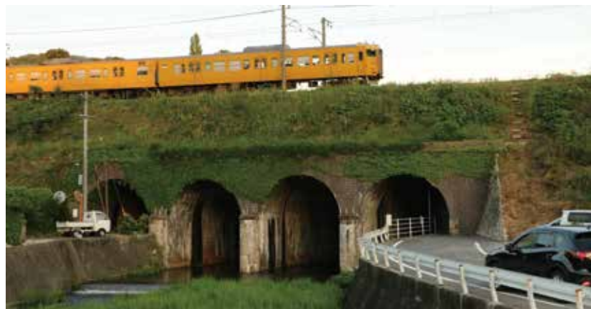
三石金剛川拱橋（上り線側）径間 6.1 × 高さ 6.4 × 長さ 22.2 m × 四列 アーチ橋の第一径間は道路、第二・第三は金剛川、第四は水路兼生活道として使用される。上り線側は焼過煉瓦と呼ばれる濃色の煉瓦が使われている。
