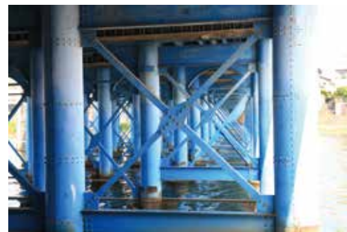
鋼管同士をつなぐアーチ、幾何学的なアングル材とあいまって、林立する橋脚が独特のモニュメントを形成。1 本の橋脚は縦に 6 個をつなぐ。
