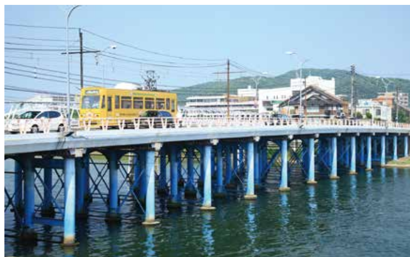
多重の鉄管柱橋脚を有するわが国最古級の大型 I 桁橋は、今も大正モダンを伝える。
