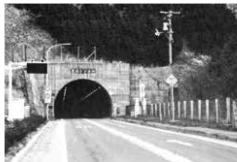
黒尾トンネル（1970） （『写真に見る国道 53 号の今昔』より転載）
