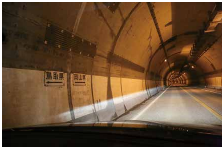
黒尾トンネル ループ橋をはじめ多くの橋でつないだ国道 53 号は、積雪の心配なく通行できるようになった。
