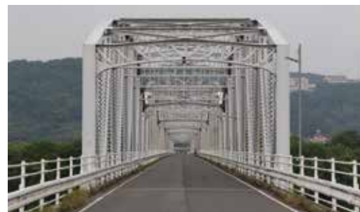
ワーレントラスの旧霞橋
