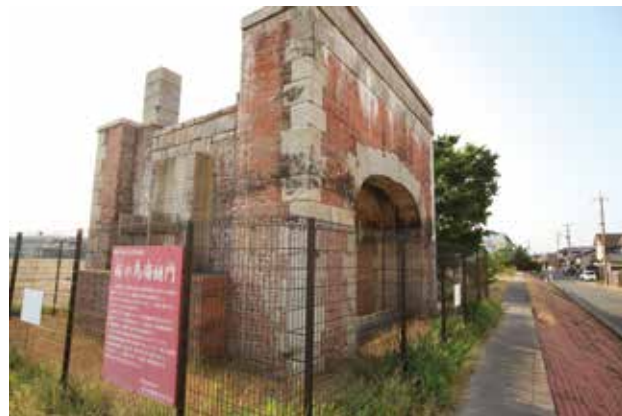
桜の馬場樋門
