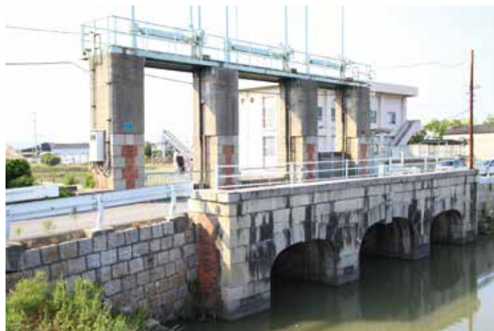
丙川三連樋門
