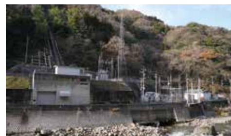
新帝釈川発電所
