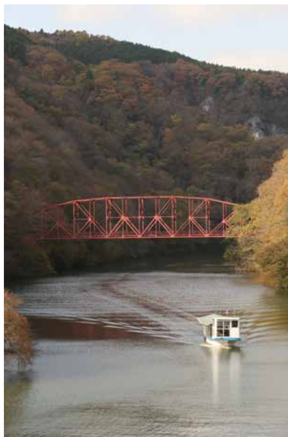
国定公園に溶け込む歩道橋 旧紅葉橋の幅員は 3.6 m だったが、探勝歩道とするために幅員を 2.0 m、延長 84.0 m で移設された。
