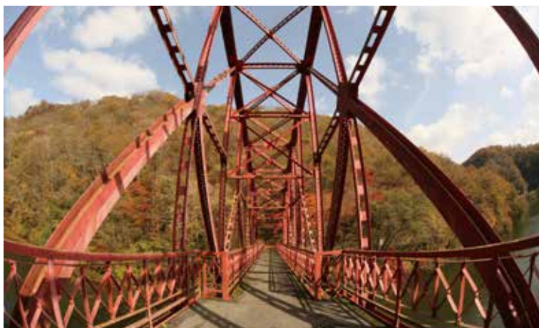
選奨土木遺産「神龍橋」（旧紅葉橋） 戦前に架設された道路用の単純トラス橋としては最長スパンを誇っていた。
