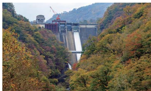
貯水・発電を行いながら嵩上げされた王泊ダム 60 年を経て放流管の交換中（2019.11.3）
