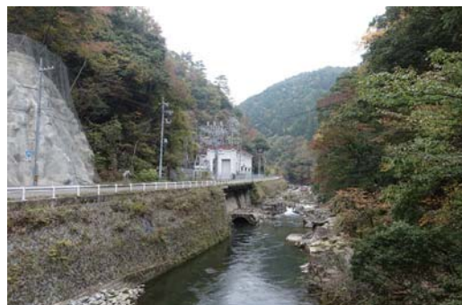
下山発電所 発電所建屋下に放水口がみえる。
