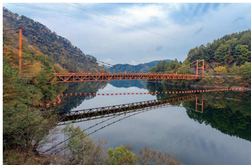
仙水湖に映える新王泊橋 橋長 151.75 m、単径間 2 ヒンジ補剛構吊橋
