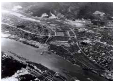
工事中の太田川放水路（昭和 37 年） 終戦前後の中断を経て再開され、大詰めの方分点付近の工事が始まった頃。
