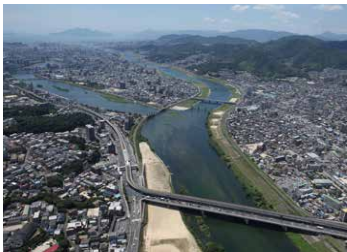
太田川放水路（平成 24 年） 大芝（左）、祇園水門（右）分岐から下流を望む。手前は祇園新橋。
