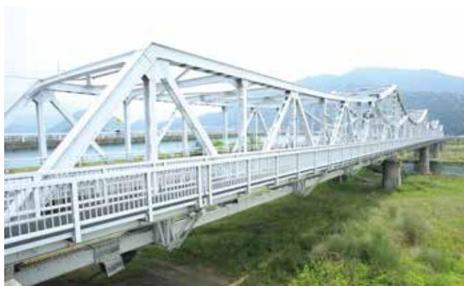
二代目鋼橋 橋長 323.1m 幅員 9.0m
