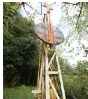
潮流信号機 昼間、黒色長方形板と紅色円形板で潮流の方向を示し、夜間は大浜埼灯台から潮流に合わせた光を出して船舶に知らせた。
