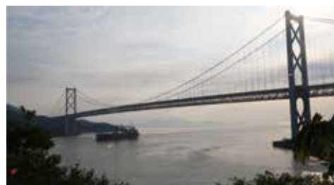
布刈瀬戸に架かる因島大橋
