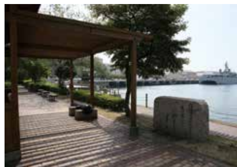
旧呉鎮守府兵器部護岸および関連施設 整然と積まれた花崗岩の護岸、巧みに加工された石階段、クレーン等、旧呉鎮守府兵器部の施設が保存され、公園化されている。
