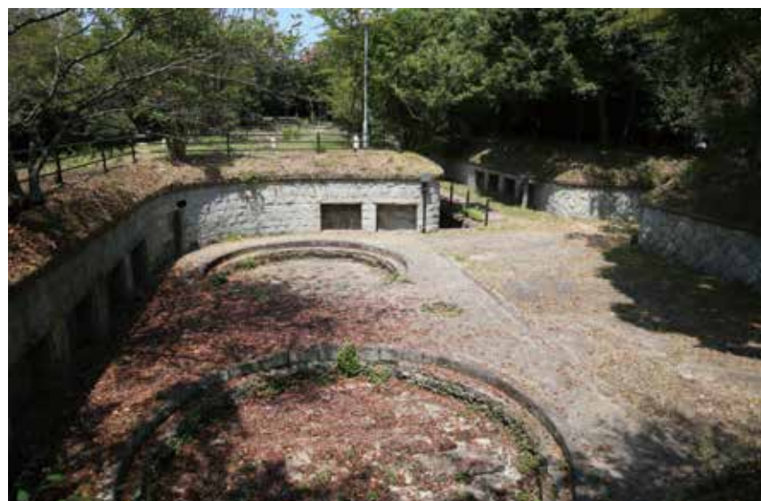
現存する最大級の呉（広島湾）要塞の砲台施設「砲座跡」 砲台山森林公園として整備されており、保存状態も良好で学習の場となっている。28 センチ榴弾砲が 6 門配備されていた。
