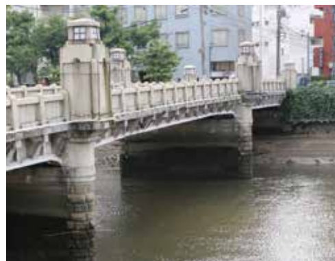
コンクリート橋に見えるが、鋼鈹桁の外表面をコンクリートで被覆し、石造りの高欄や親柱と調和させた京橋
