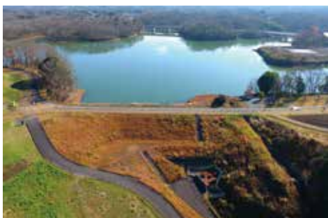
国兼池の堰堤。堤体左岸に洪水吐きがある。
