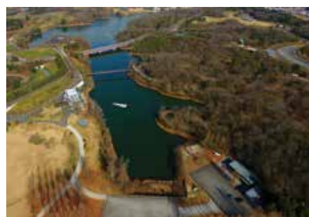
本村川から暗渠で国兼池に導水されている。
