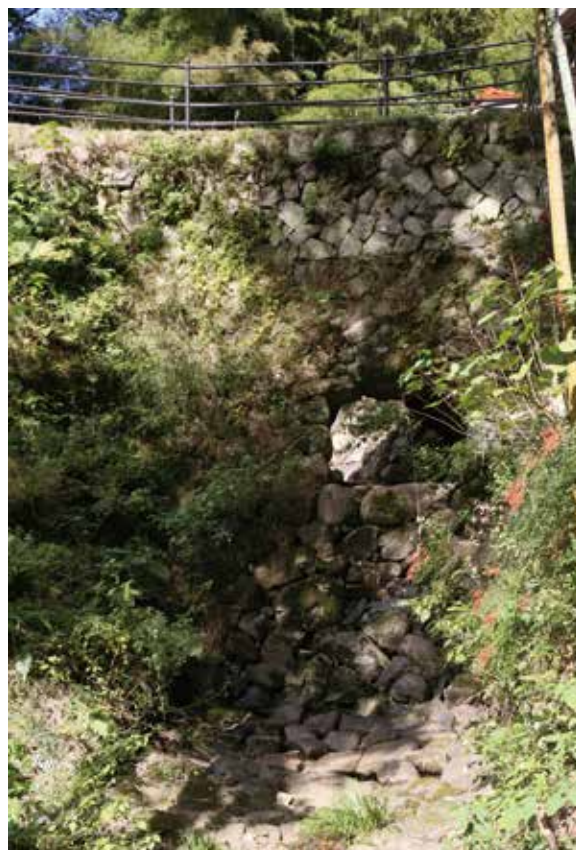
下流側から見る金名の郷頭 本体の強度を増すために、上流から下流まで栗石を敷き固めた上に、直径30～60cmの平石を敷いて川床としている。
