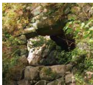
金名の郷頭導水部(下流側)
