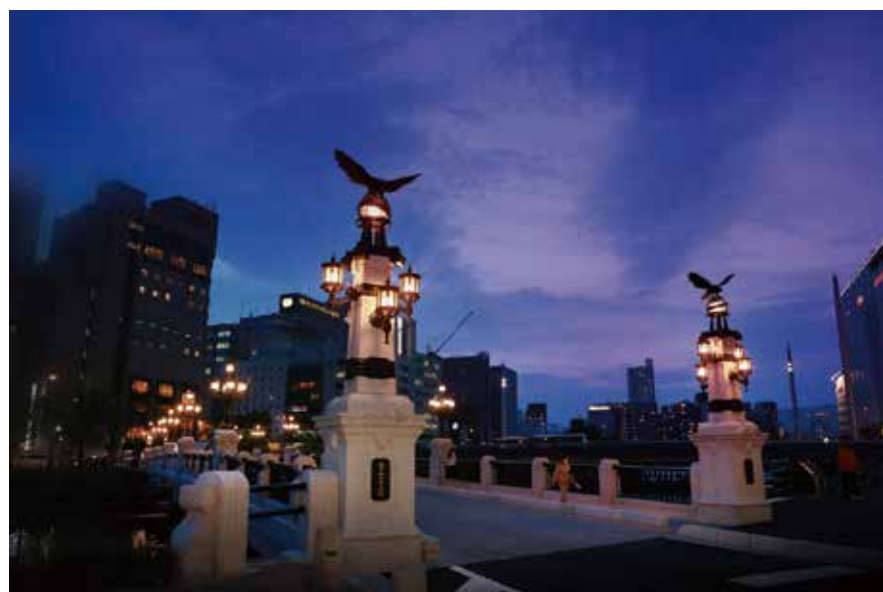
復元された猿猴橋（平成28年） 3径間連続+2径間連続鉄筋コンクリートT桁橋 橋長62.5m 大正15年3月16日（供用開始）完成
