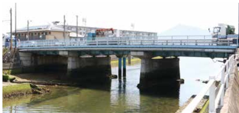
恵川新橋 3径間ゲルバー鋼鉸桁橋 橋長36.62m
