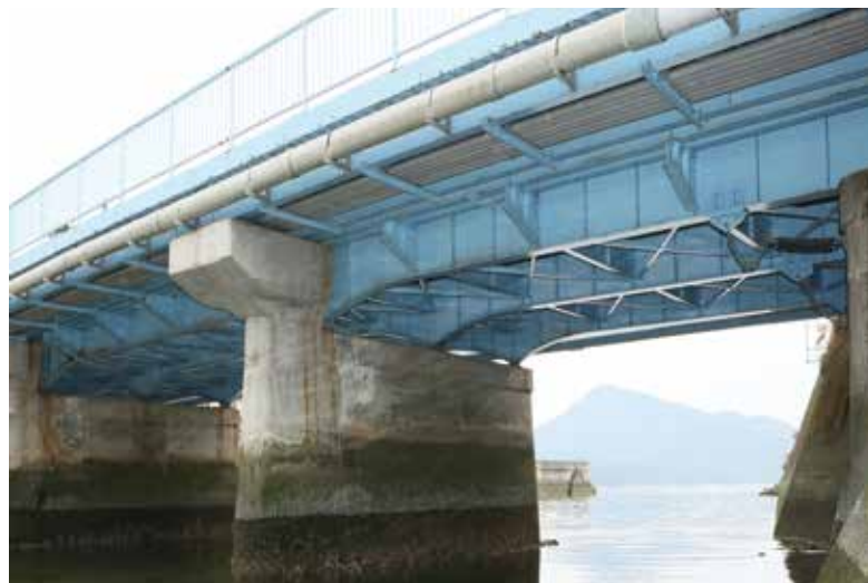
恵川新橋 鋼橋の裏面を見ると、リベットはなく突合せ溶接で施工している。橋台は半重力式躯体に4mの鉄筋コンクリート井筒基礎、橋脚は半重力式躯体に10mの鉄筋コンクリート井筒基礎である。
