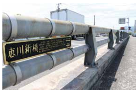
突合せ溶接の説明が記された橋銘板
