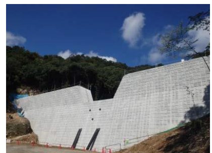
砂防堰堤の建設
