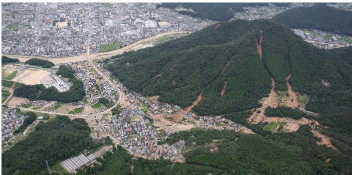
広島市安佐北区可部東地区の土砂災害【国土地理院撮影】
