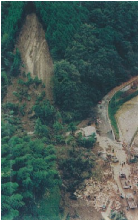
上空⑤と側面⑥から見た旭町栃原の斜面崩壊現場（岡山県土木部砂防課）
